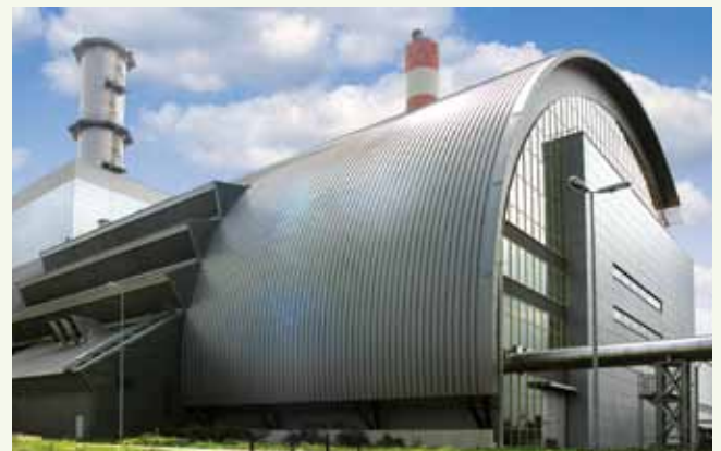
Links: Fernheizwerk Spittelau (Fernwärme Wien) Oben: Fernheizwerk Linz Mitte (LINZ AG) Unten: Fernheizwerk Inzersdorf (Fernwärme Wien)
