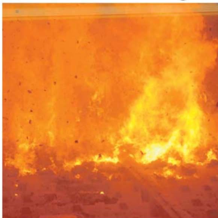
Jährlich werden bei der AVE rund 300.000 Tonnen Abfall thermisch verwertet. Die Abwärme wird nun in das Fernwärmenetz eingeleitet.
